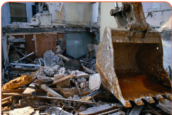
Для очистки огромного количества обломков после землетрясения часто требуются большие машины
