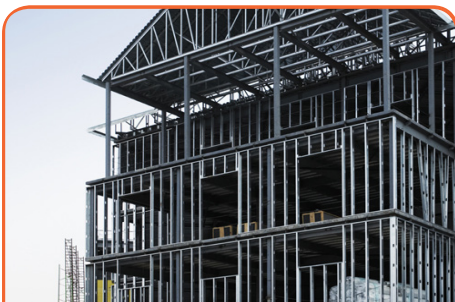
Здания со стальными каркасами, как правило, считаются более устойчивыми к землетрясениям
