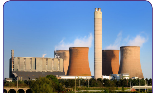
Электростанция и ее охлаждающие башни
